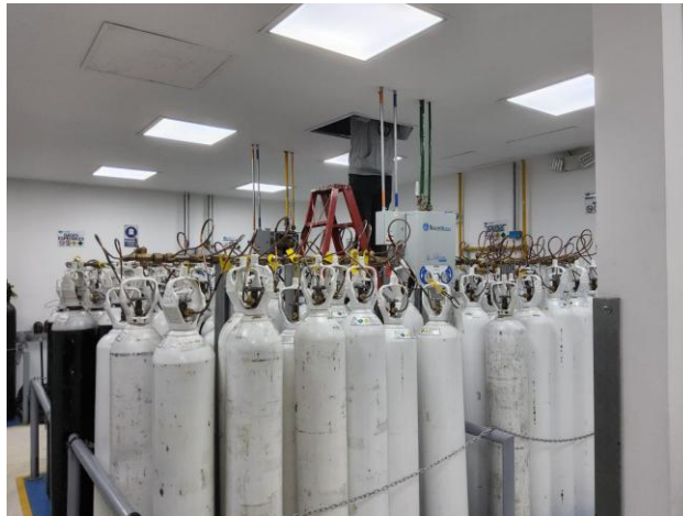
Imagen 1: Manifold de oxígeno Medicinal 2x24, ubicado en central de gases HOMIL. Fuente: Propia
