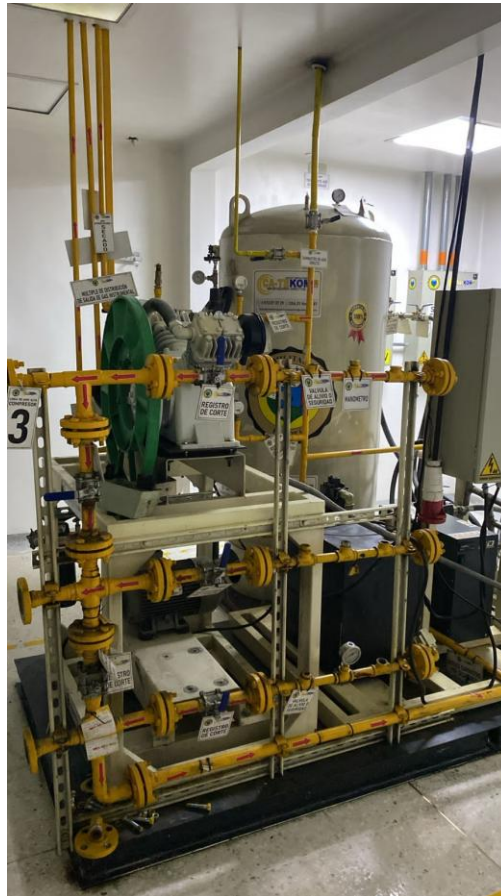
Imagen 5: Compresor de aire instrumental ubicado en central de gases HOMIL Fuente: Propia
