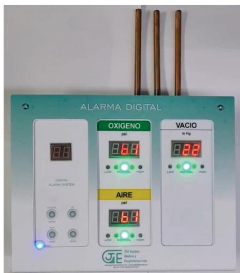
Imagen 16: Ficha técnica y características de alarma de área digital Fuente: Propia
