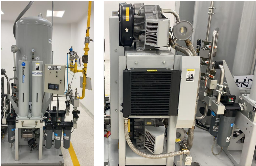
Imagen 4: Compresor de aire medicinal ubicado en central de gases HOMIL Fuente: Propia
