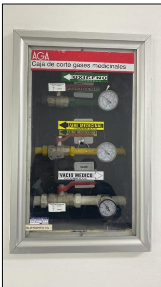
Imagen 8: Ubicación e imagen de caja de corte de 3 vías ubicada en ala central HOMIL Fuente: Propia
