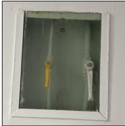
Imagen 12: Caja de corte en nivel 03 ala central sin funcionamiento Fuente: Propia
