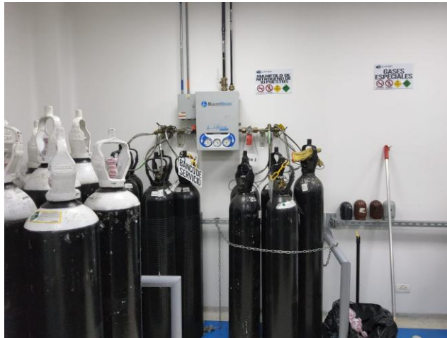
Imagen 2: Manifold de nitrógeno 2x5 ubicado en central de gases HOMIL. Fuente: Propia
